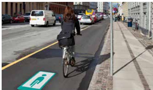
Asfaltbelægning på cykelsti, foto Ursula Bach
