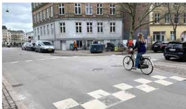
Hævet flade, Wesselsgade/Baggesensgade
