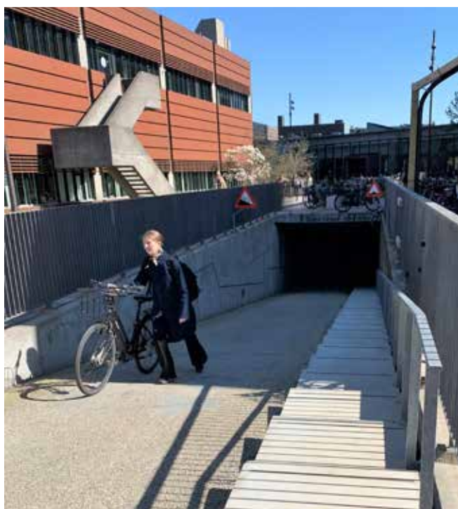
Tilkørsel til cykelkælder ved Panum
