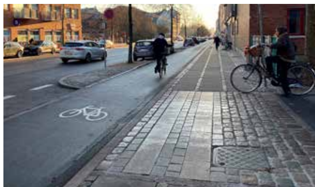
Overkørsel med gennemført cykelsti og fortov på Jagtvej
