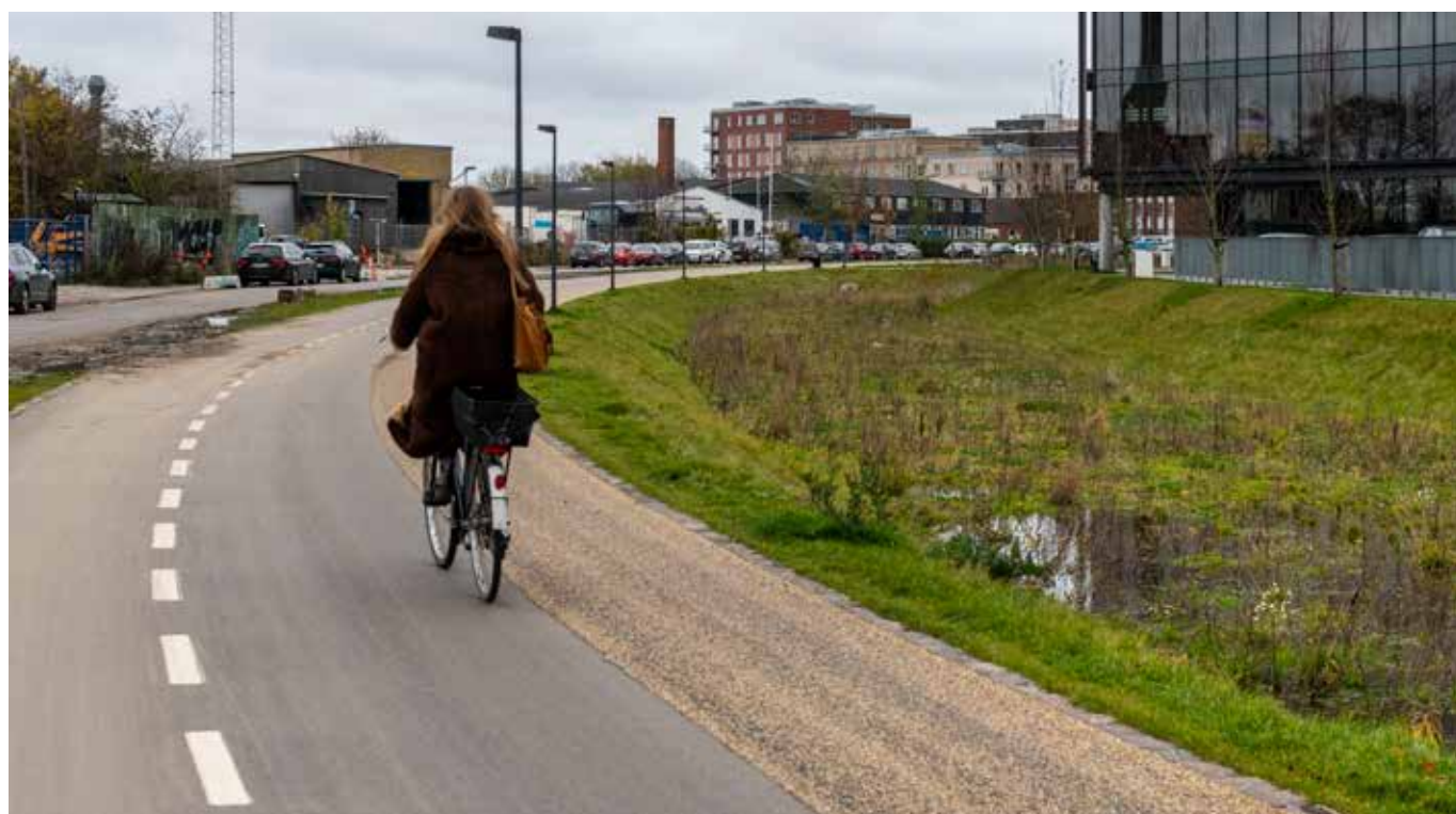
Klimatilpasning ved Amagerbanen, foto Troels Heien
