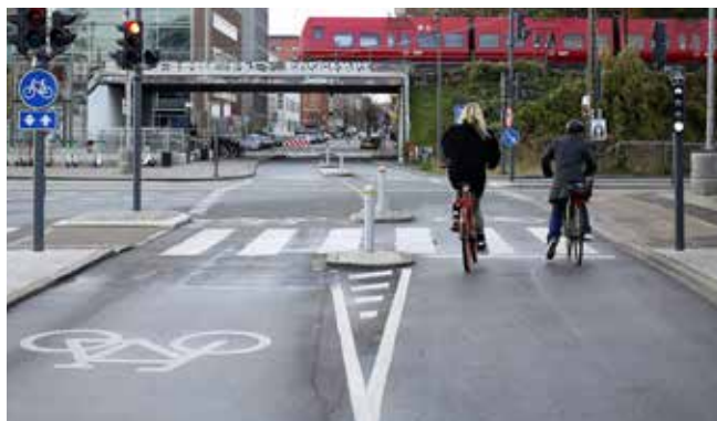
Dobbeltrettet cykelsti med støttehelle, steler og spærreflade på Århusgade
