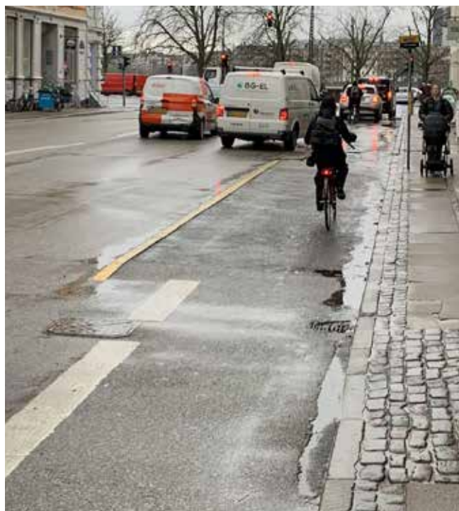
Forstærket cykelbane ved busstoppested på Classensgade
