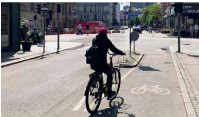
Slipseløsning med midterhelle på Studiestræde
