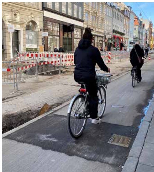
Reparation på hele cykelstibredden på Gothersgade
