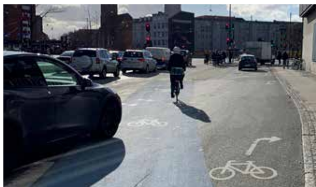
Cykelbane mellem ligeud- og højresvingsbane med afkortet cykelsti, Vibenshus runddel/Jagtvej
