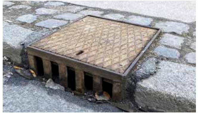
Sideindløbsbrønd på Gothersgade
