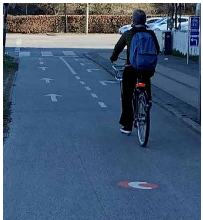
Kanalisering i ligeud- og højresvingsbane på Ørestads Boulevard
