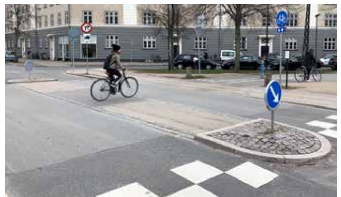
Cykelstikrydsning med midterhelle, Nørrebrodden/Stefansgade
