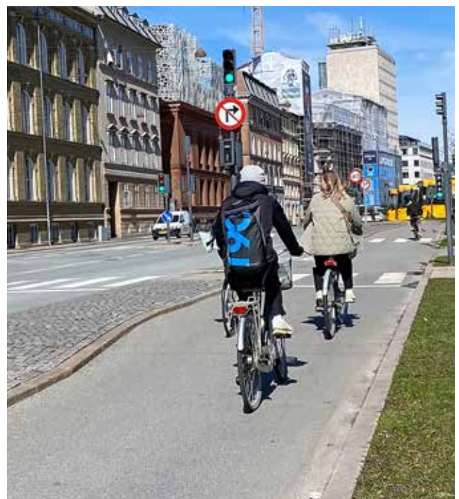
Udvidet cykelsti på Nørre Voldgade
