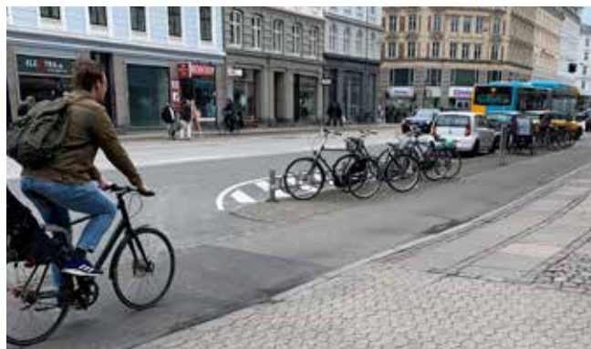
Cykelparkering kombineret med spærreflade, Frederiksborggade/Nansensgade
