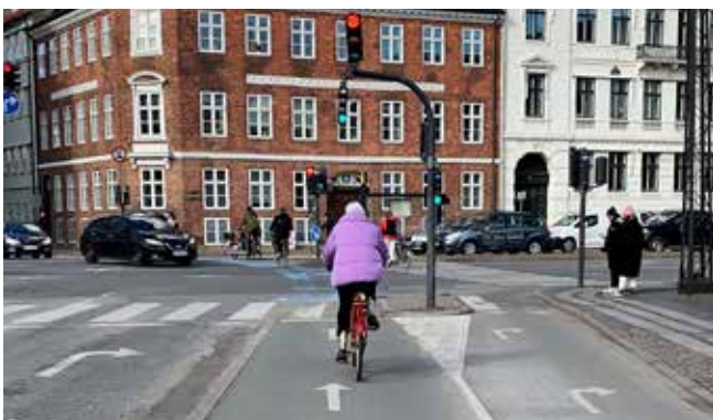
Fremført cykelsti med separat regulering, Havnegade/Holmens Kanal
